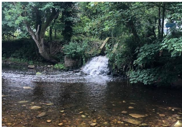
Fig. 16. Final effluent outfall, Ilkley STW
